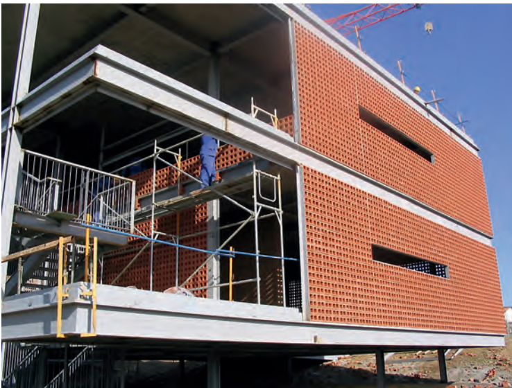
Figura 9: ejecución de fachada con piezas cuadradas de celosía cerámica.
