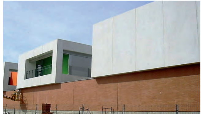
Figura 8: fachada pesada realizada con panel prefabricado de hormigón blanco reforzado con vidrio (GRC).
