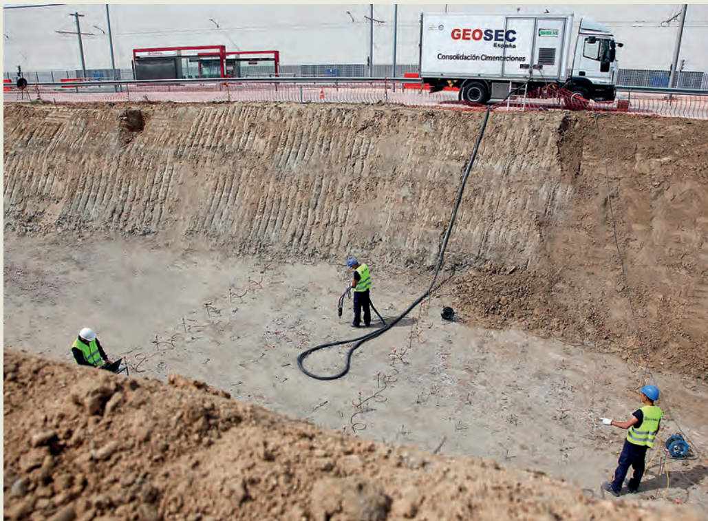
Consolidación de explanada de vial de nueva construcción, en Madrid.
