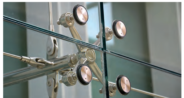
Figura 4: piezas de fijación de fachada de vidrio abotonado.
