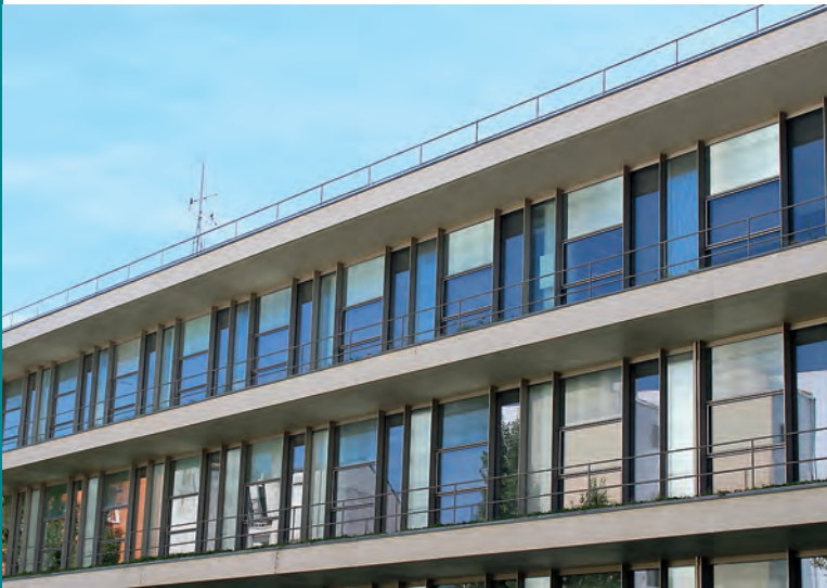
Figura 11: fachada-panel con subestructura de aluminio anodizado y lunas de vidrio con áreas tintadas y no tintadas. Sobresale un voladizo con inclusión de vegetación sobre él.
