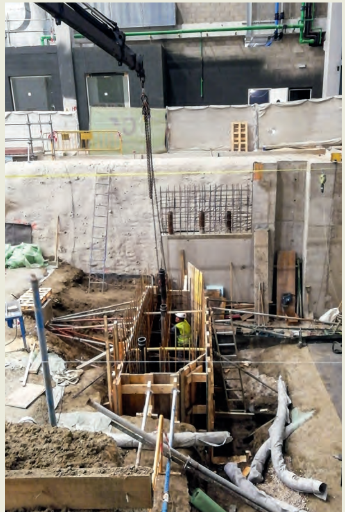
Las imágenes muestran el proceso llevado a cabo: una vez hormigonados los muros y encepados, se procede a la ejecución de la hincas desde la cota superior de los encepados.
