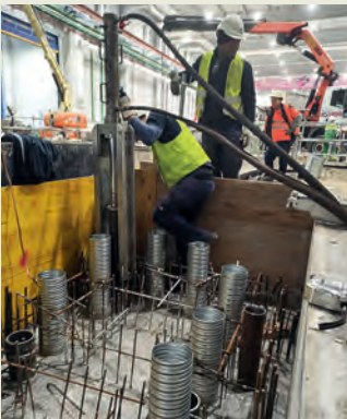
Las imágenes muestran el proceso llevado a cabo: una vez hormigonados los muros y encepados, se procede a la ejecución de la hincas desde la cota superior de los encepados.
