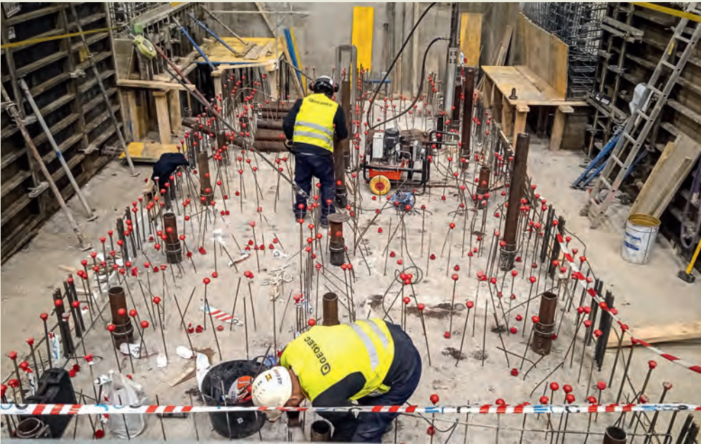
Las imágenes muestran el proceso llevado a cabo: una vez hormigonados los muros y encepados, se procede a la ejecución de la hincas desde la cota superior de los encepados.
