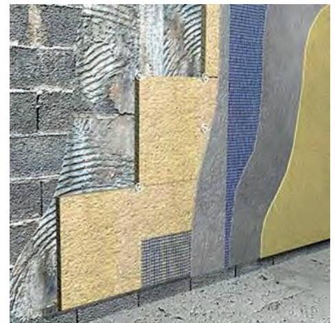
Fig. 7: infografía con la sucesión de capas a disponer en un sistema patentado de aislamiento térmico por el exterior.
