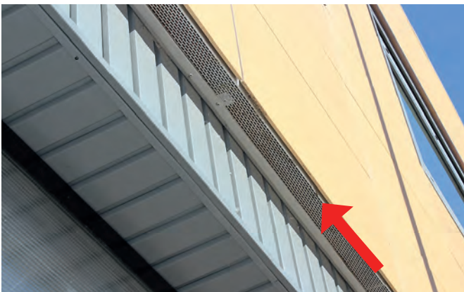
Fig. 4: vista de la rejilla inferior de ventilación de la cámara de aire de una fachada ventilada.
