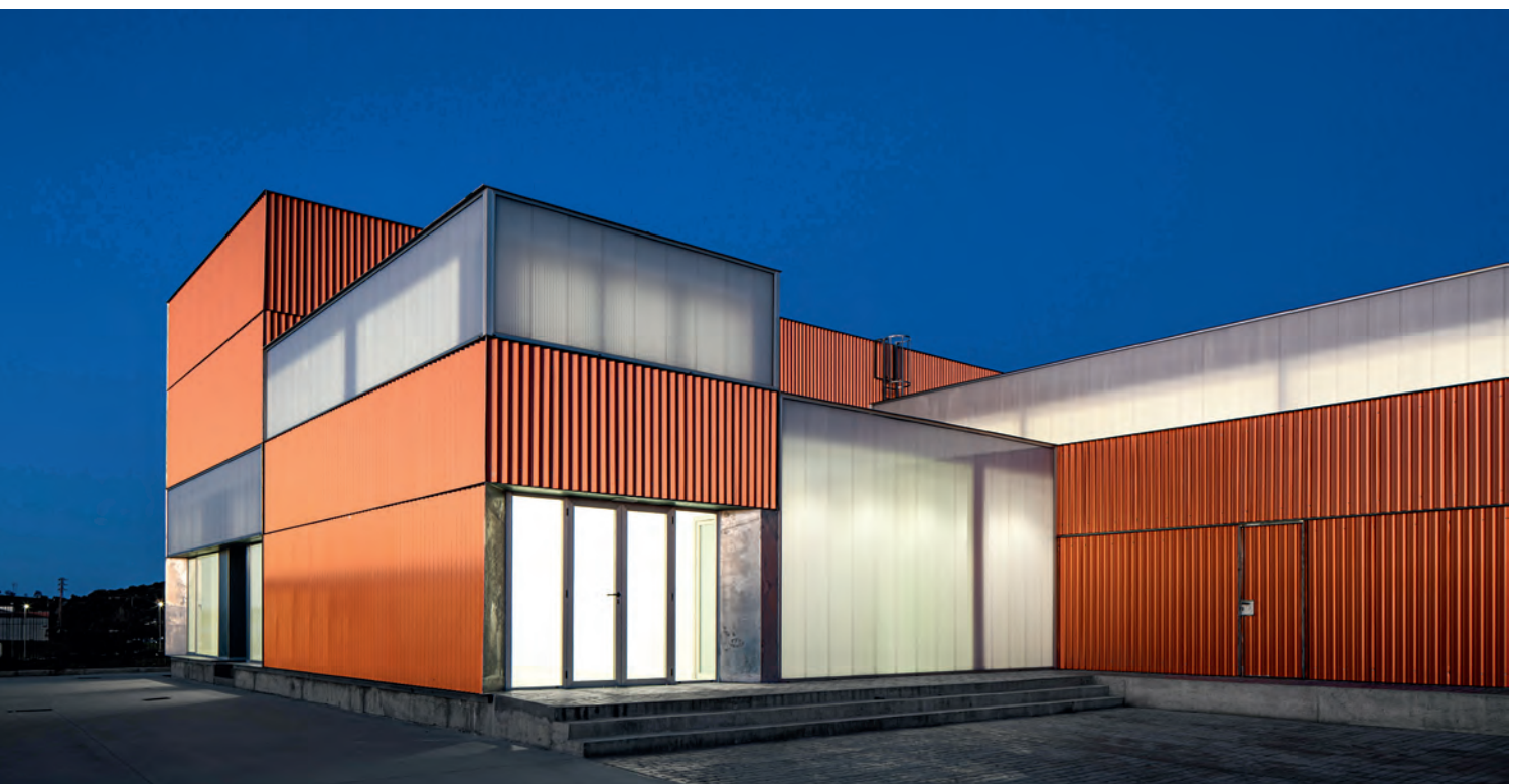
UN SISTEMA DE PANELES DE POLICARBONATO CELULAR CONFORMA LA ENVOLVENTE TRANSLÚCIDA
