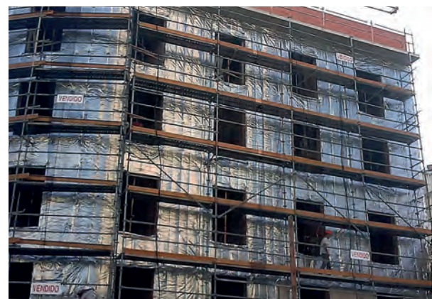
Fig. 1: colocación de aislamiento de aluminio reflectivo.
