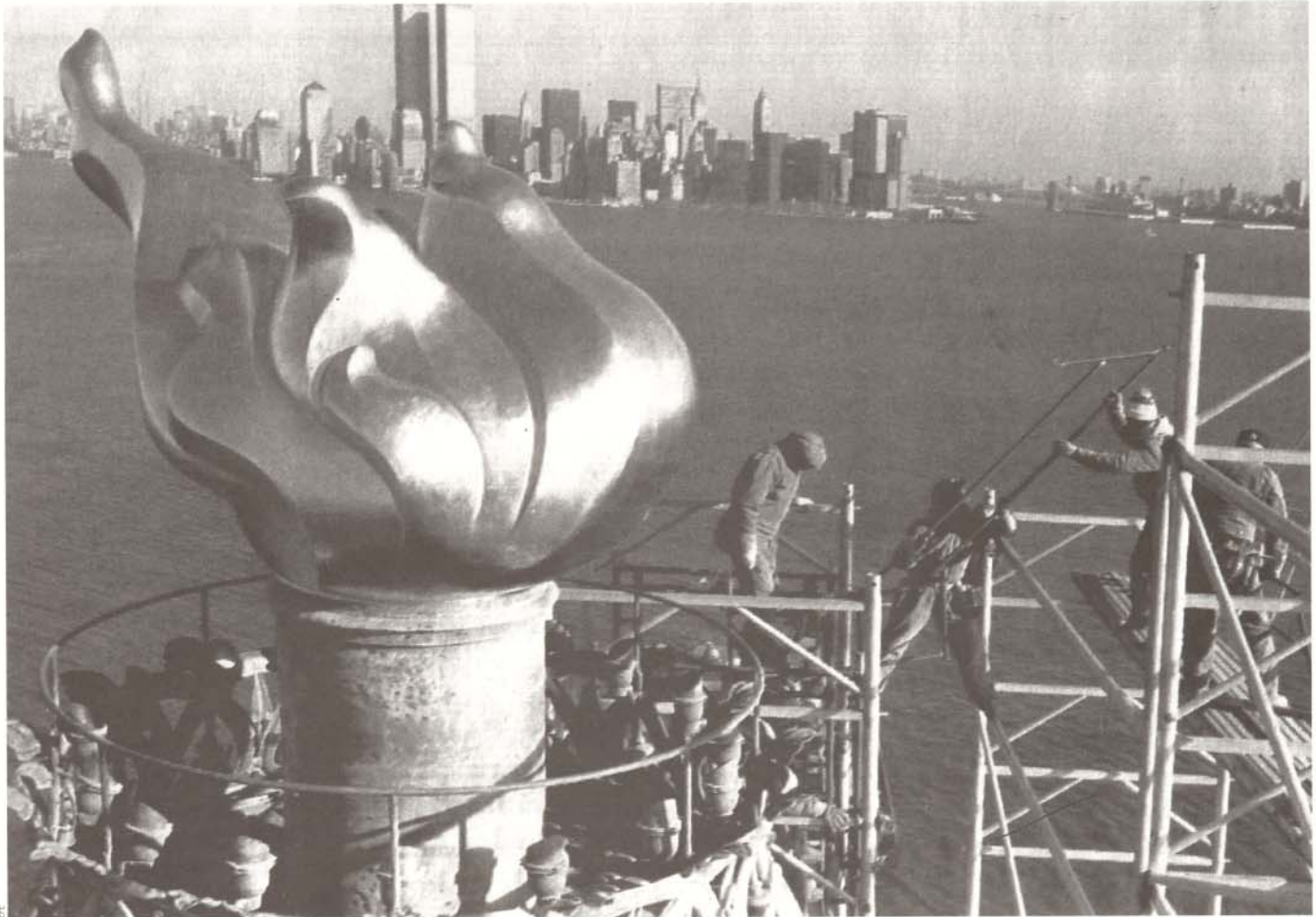
Las desviaciones sobre los plazos o los costes se persiguen semana a semana.
