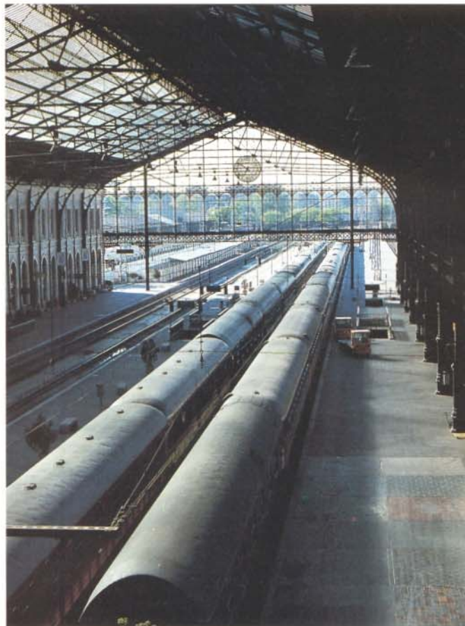
PRÍNCIPE PÍO Una clásica cubierta sobre entramado de hierro para cubrir los andenes nos hace volver la vista atrás.
