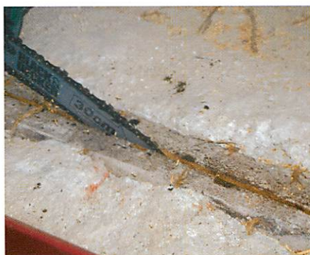
Corte de la madera con sierra motorizada.
