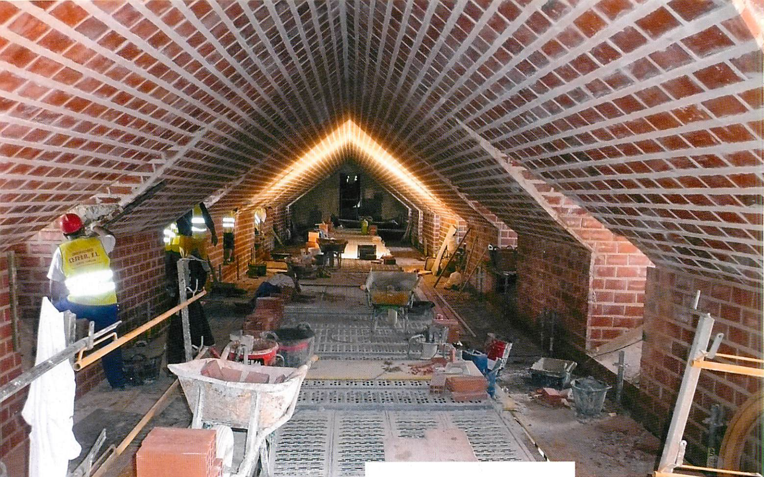
Las cubiertas se han repuesto con el sistema de fábrica armada para evitar empujes a los muros.
