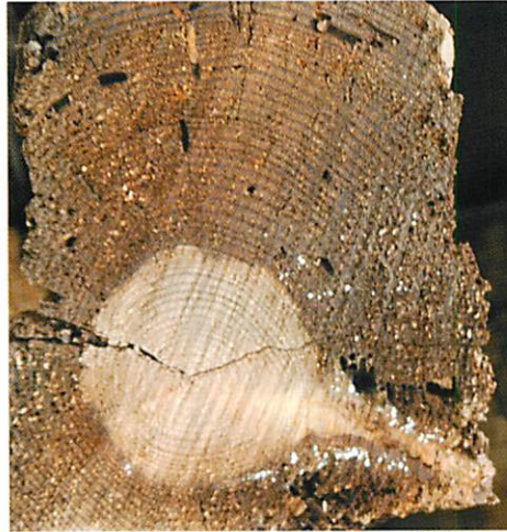
Testa de vigueta de madera con ataque por insectos de ciclo larvario.
