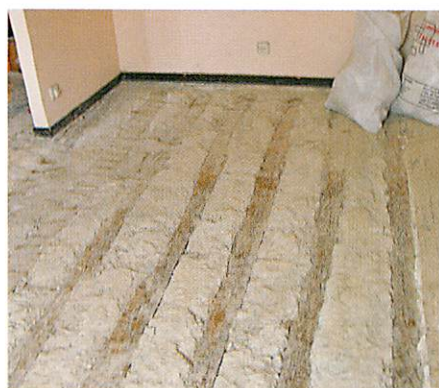
Forjado de madera tras retirada de solado.
