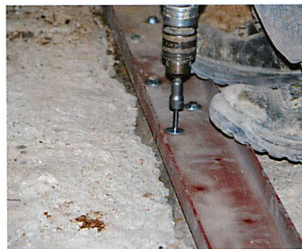
Atornillado de tirafondos de forma mecánica.
