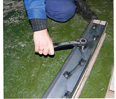
Atornillado manual en las últimas vueltas de rosca.
