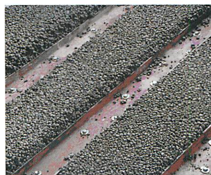
Forjado con la pieza de refuerzo ensamblada.
