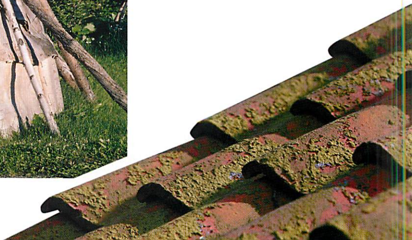
La madera ha sido la solución de cubierta para zonas de alta pluviometría. Abajo, tejas de barro cocido.
