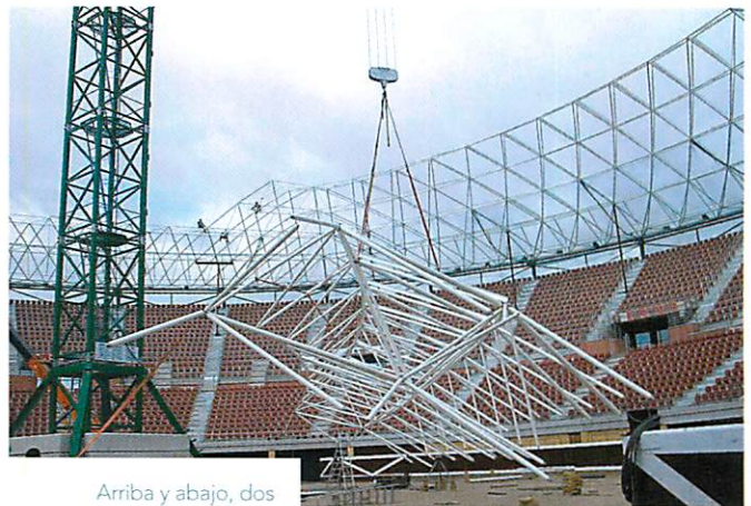
Arriba y abajo, dos imágenes del premontaje exterior. En el centro, montaje del perímetro fijo de la cubierta.
