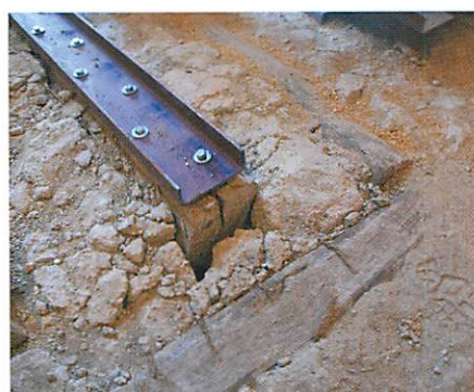
Forjado con la pieza de refuerzo ensamblada.
