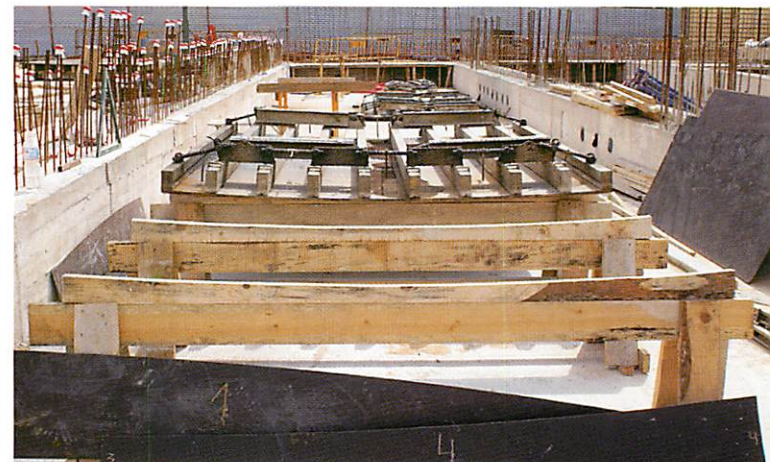
El diseño en obra del enlace de la curva descrita por los tres radios que conformaban el muro testero de hormigón se preparó y realizó a escala 1:1.
