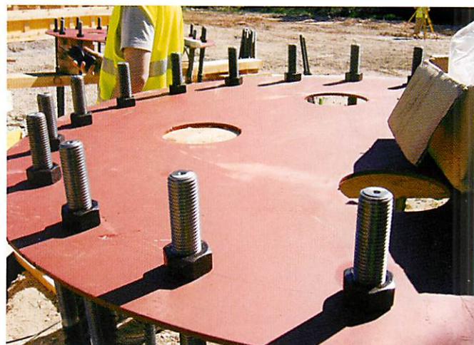
Las raíces de estos magníficos árboles de acero se hunden hasta 30 metros con grupos de pilotes de hormigón prefabricado de sección cuadrada ejecutados mediante inca.
