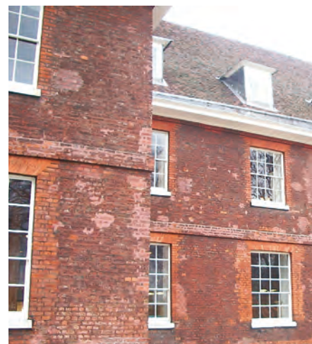
Fig. 3: fachada de un edificio de Londres.
