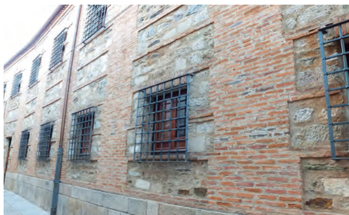
Figura 1: fachada de fábrica con mampuestos de ladrillo y piedra.
