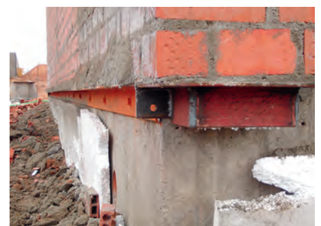
Figura 2: colocación de angulares para apoyo de fábrica en borde.
