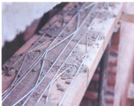
Las armaduras evitan el agrietamiento.
