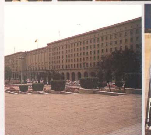
A la izquierda, José Borrell, ministro de Obras Públicas. A la derecha, el Instituto de Investigación, Desarrollo y Control de Calidad (ICCE) en Málaga.
