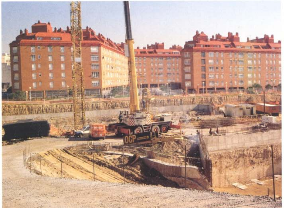
Obras de cimentación de un edificio de viviendas.
