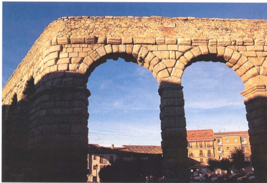
Pila 75, una estructura ejemplar para cambiar de dirección.
