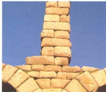
Pila de los arcos superiores.
