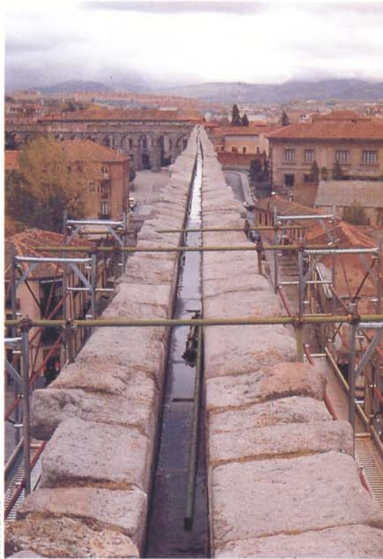
Se aprecian ligeros movimientos transversales en el canal. A la derecha, operaciones de limpieza de juntas entre sillares y toma de muestras.
