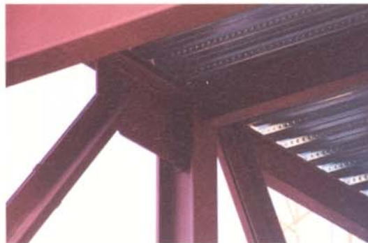
Arriba: estructura metálica de la Galería Oeste. Al lado, el "túnel" de hormigón parte de la Galería Temporal, conocido como "Fish" por sus formas curvadas. Sobre sus arcos (foto de la izquierda) se sustenta una segunda y compleja estructura metálica curviforme. Abajo, sendos detalles de arriostrado y amarre de vigas de la estructura principal.
