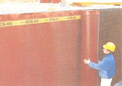
La aplicación de DELTA-MS como protección de muros garantiza una perfecta y duradera impermeabilización y un sótano seco.
