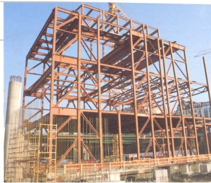
Arriba: estructura metálica de la Galería Oeste. Al lado, el "túnel" de hormigón parte de la Galería Temporal, conocido como "Fish" por sus formas curvadas. Sobre sus arcos (foto de la izquierda) se sustenta una segunda y compleja estructura metálica curviforme. Abajo, sendos detalles de arriostrado y amarre de vigas de la estructura principal.
