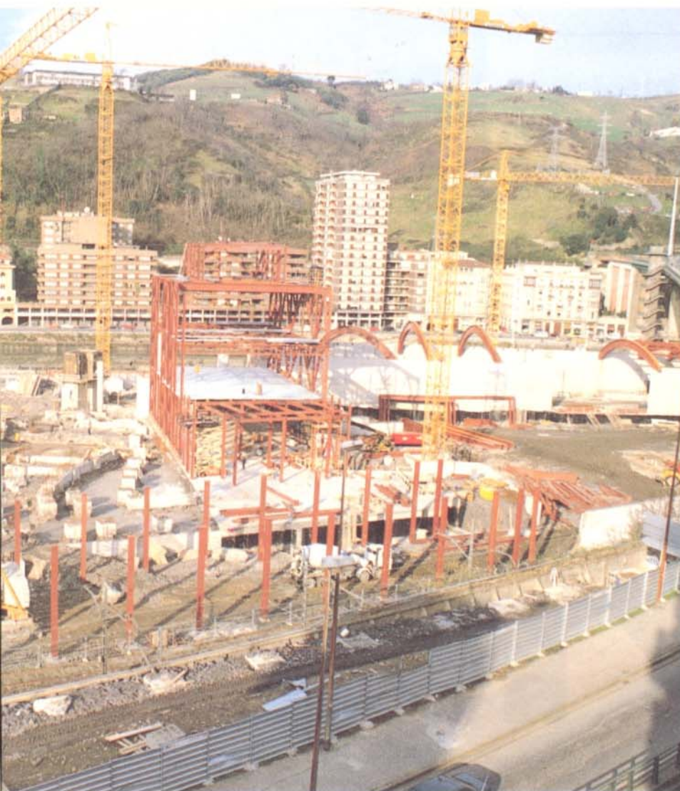
Vista general de las obras del Museo y perspectiva de la estructura metálica principal de la Galería "clásica" Este.
