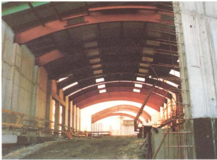
Arriba: estructura metálica de la Galería Oeste. Al lado, el "túnel" de hormigón parte de la Galería Temporal, conocido como "Fish" por sus formas curvadas. Sobre sus arcos (foto de la izquierda) se sustenta una segunda y compleja estructura metálica curviforme. Abajo, sendos detalles de arriostrado y amarre de vigas de la estructura principal.
