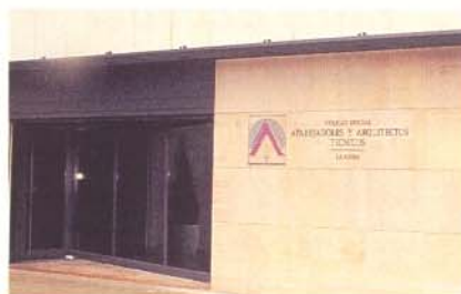
Vistas de la reforma.
