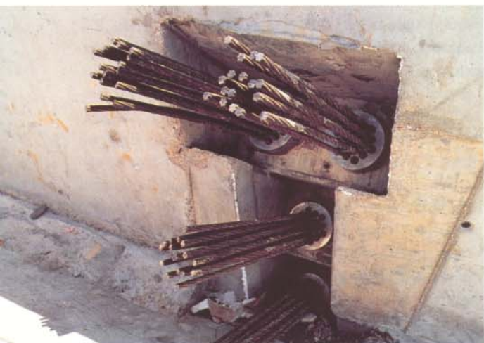
Detalles de la ejecución de la obra: arriba, espectacular cimbrado del anillo perimetral del graderío. A la izquierda, cordones del postensado y armado de la viga a gran altura. (Fotos cedidas por la propiedad).
