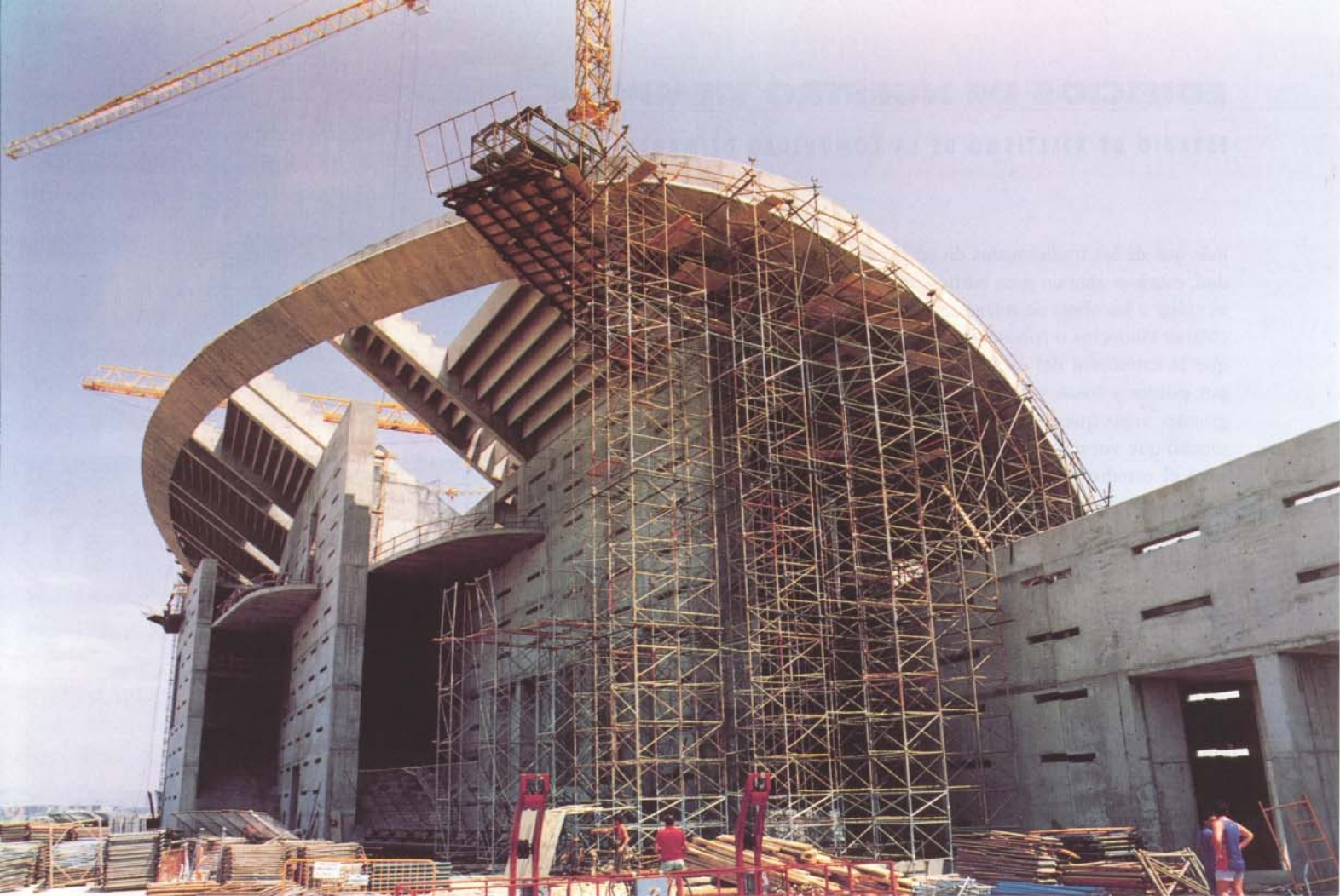
Detalles de la ejecución de la obra: arriba, espectacular cimbrado del anillo perimetral del graderío. A la izquierda, cordones del postensado y armado de la viga a gran altura. (Fotos cedidas por la propiedad).
