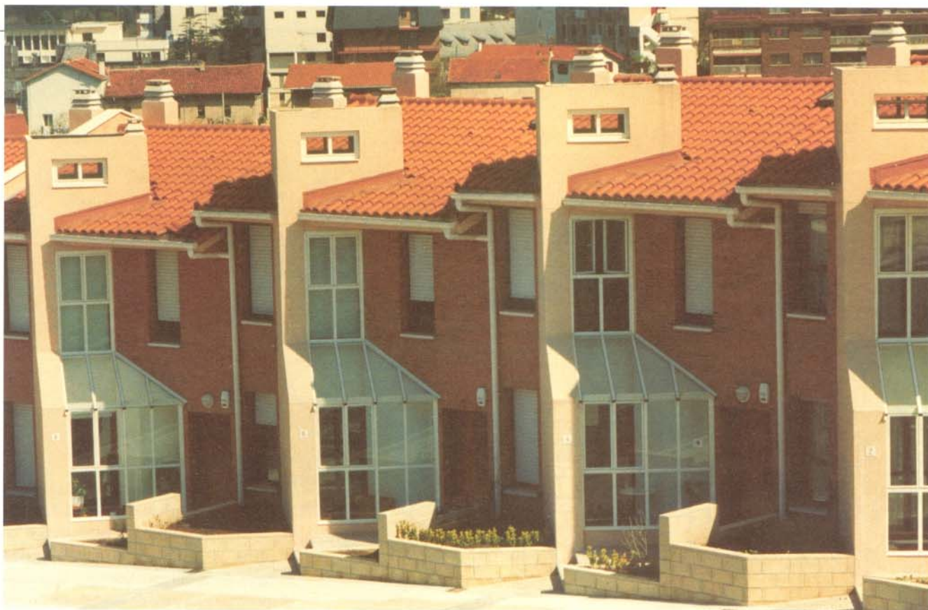
Viviendas bioclimáticas de protección oficial en Intxaurreondo, promovidas por la Asociación de la Prensa de San Sebastián.
