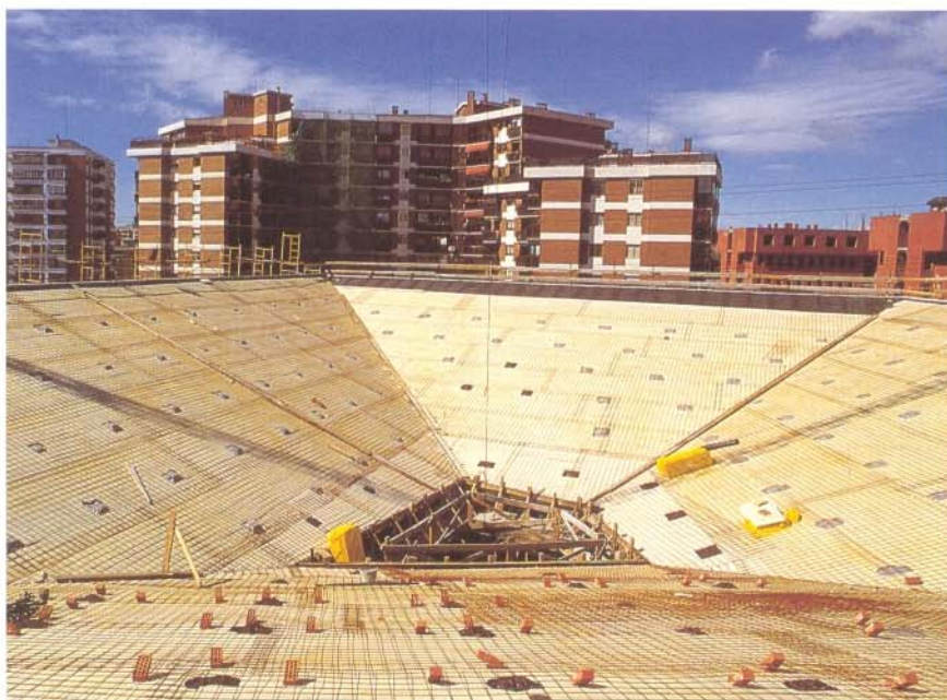
La cubierta del edificio es inclinada y realizada en hormigón a cara vista.
