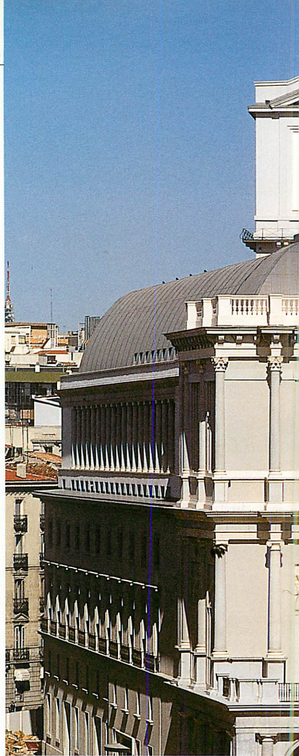
Fachada principal del Teatro y detalles arquitectónicos del edificio.
