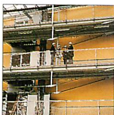
Asesoramiento personal en el lugar de obra
