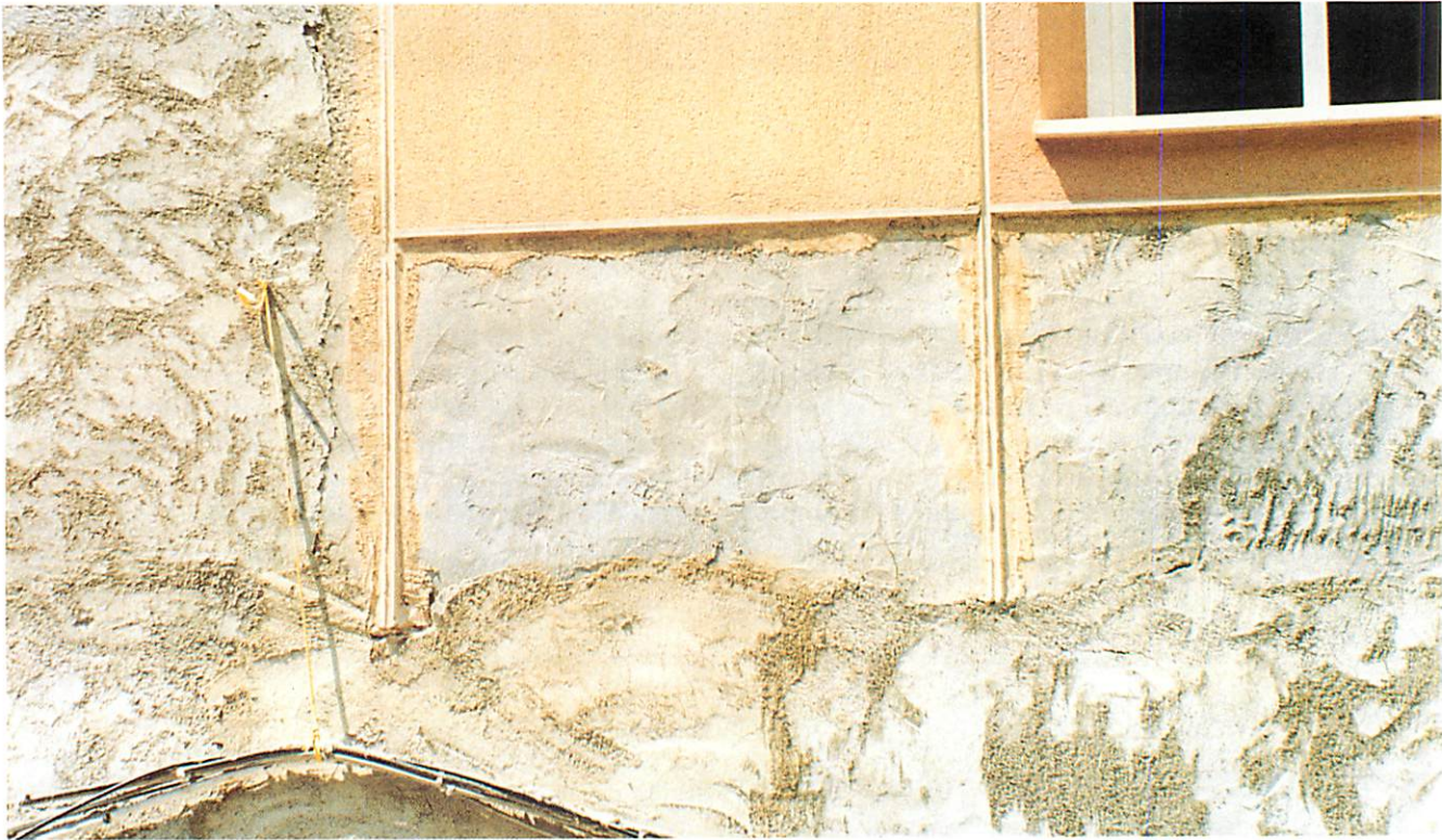
Los “monocapas” aparecieron como alternativa a los revocos tradicionales y se impusieron por su facilidad de aplicación.
