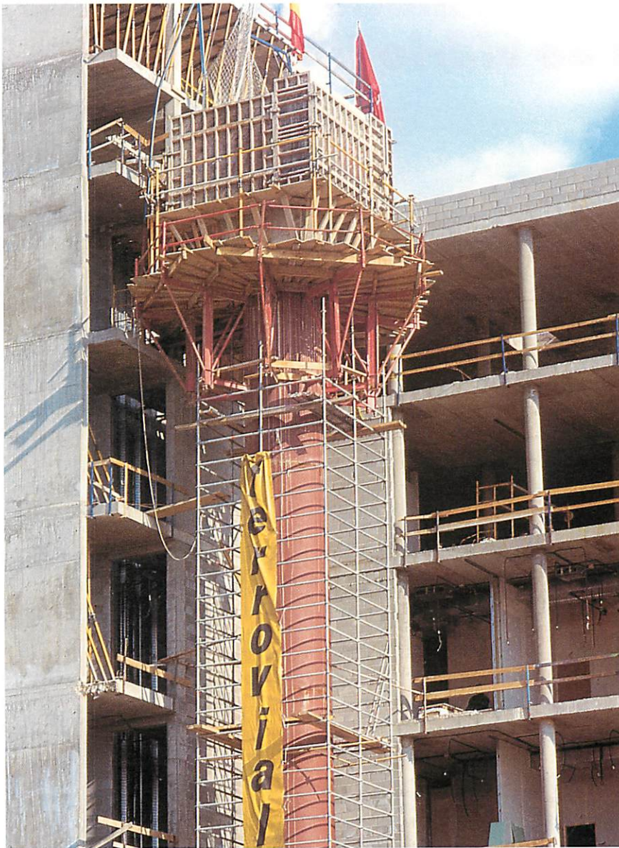
La Torre de Comunicaciones tiene una altura de 75 metros.
