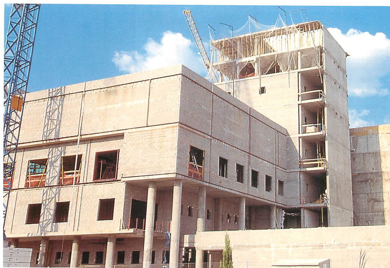
La edificación consta de seis volúmenes, separados funcional y estructuralmente mediante juntas de dilatación.
