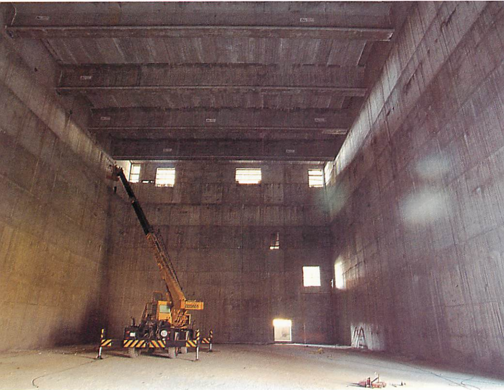
La ejecución de los platós ha presentado especiales dificultades.
