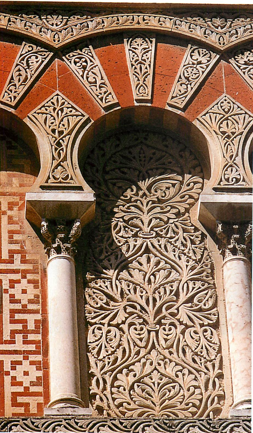
Detalle de la Mezquita. En la página anterior, puente de origen romano.
