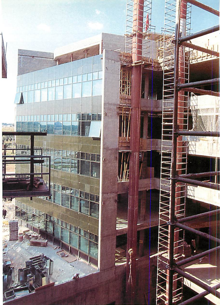
La fachada muro cortina, de color verde, es modulada y reflectante.
