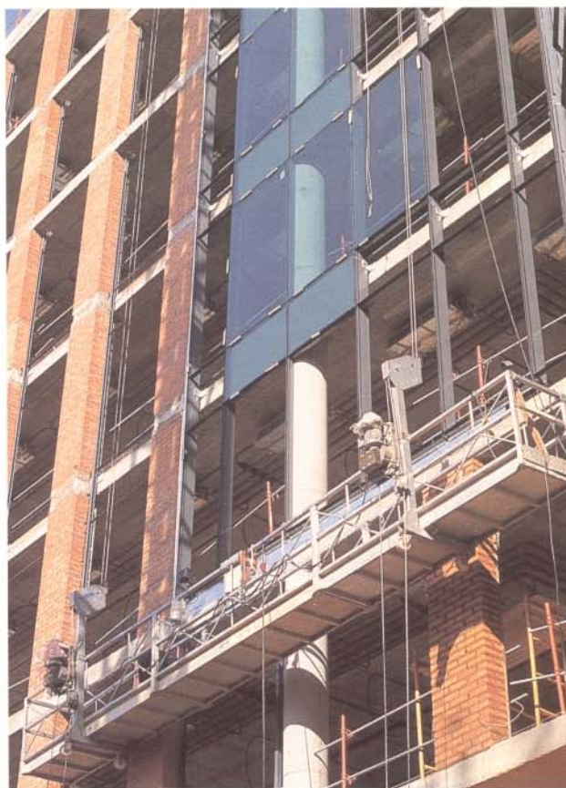
La fachada es mixta: muro cortina y granito gris.
