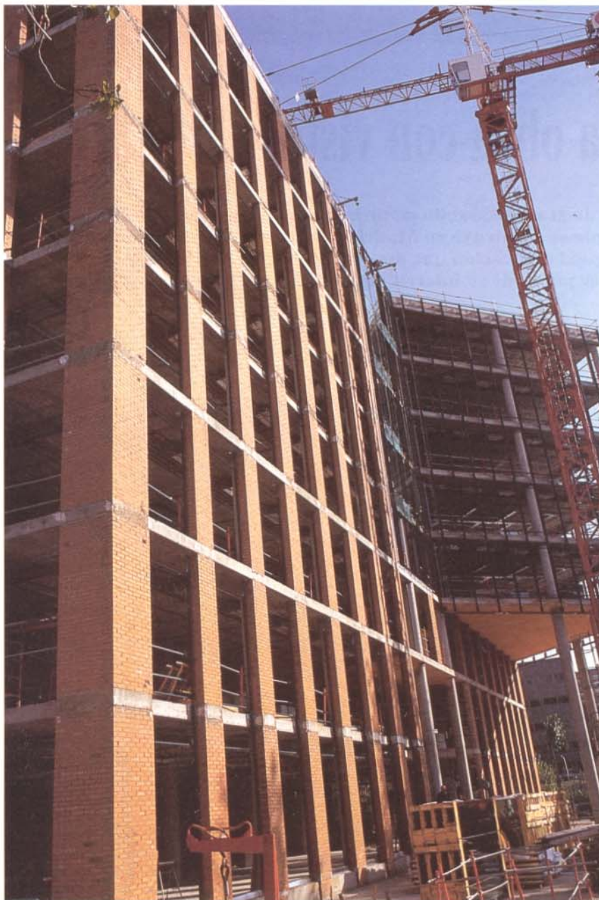
El conjunto de la estructura portante se ha realizado en hormigón armado.
