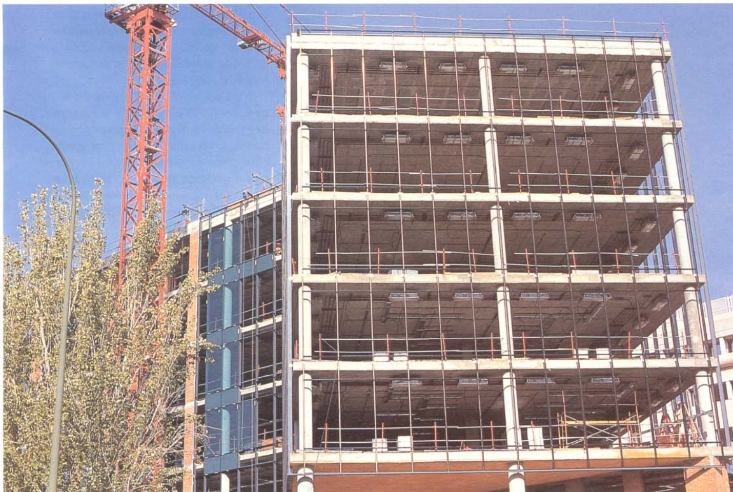
El edificio de oficinas se inaugurará en la primavera de 1997.
