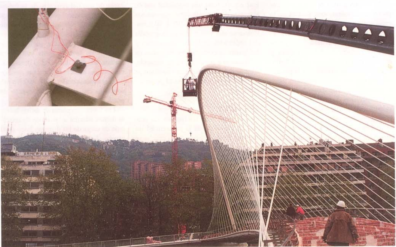
Colocación de las miras reflexivas y bandas extensométricas en el arco tubular de la pasarela de Campo Volantín.
