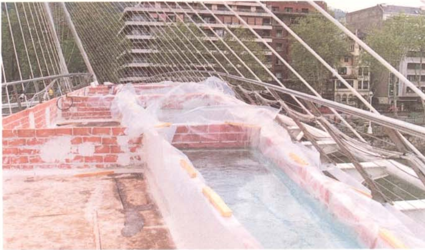
Una de las fases de la prueba con sobrecarga de agua.
