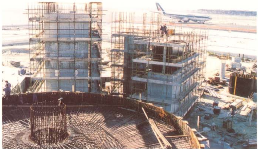
Obras de ampliación del aeropuerto de Fiumicino (Roma).
