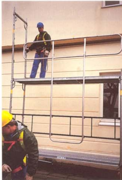
Utilización de un "marco montaje".
