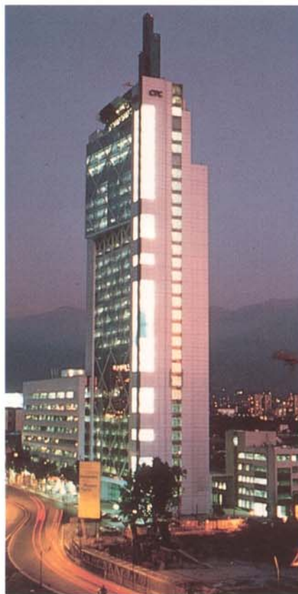
Edificio Telefónica (Chile).
