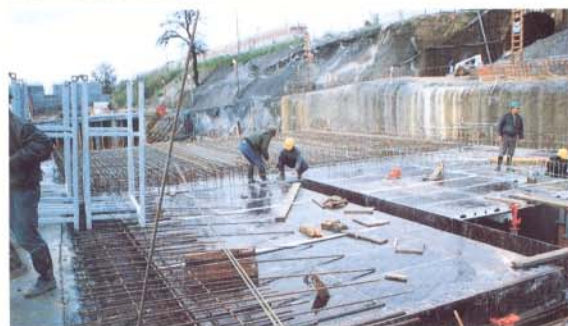
Diversas fases de la cimentación y del encofrado de los arcos de la estación ferroviaria.
