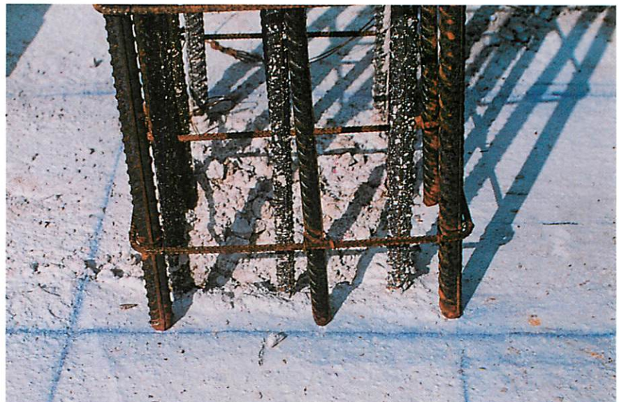
Las soldaduras en obra deberán ser autorizadas.
