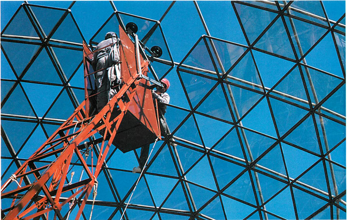
Por el cénit de la estructura exterior se introdujo un brazo articulado que permitió el montaje de la estructura interior.
