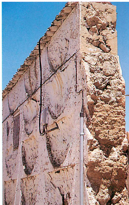
Sección real de una fábrica de tapiado.
