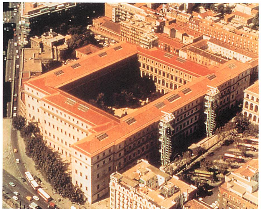
Se añadirán 16.000 m 2 a un edificio proyectado inicialmente como hospital.
