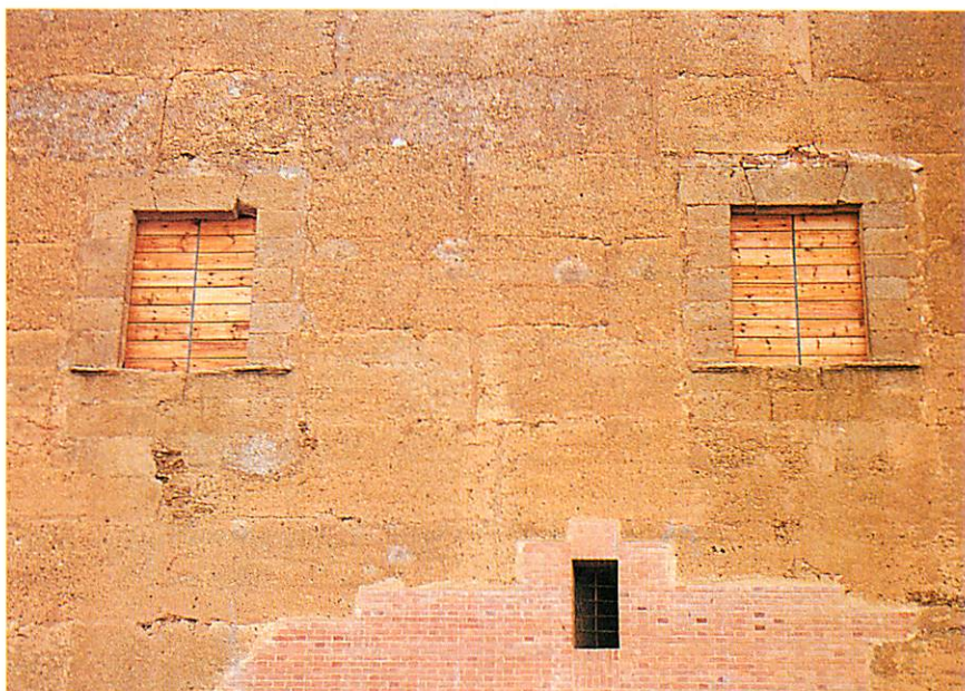
Rehabilitación del Palacio de Toral de los Guzmanes (León).
