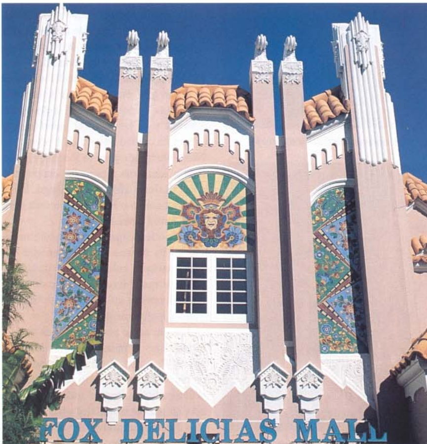
Centro comercial en la ciudad de Ponce, en Puerto Rico.
