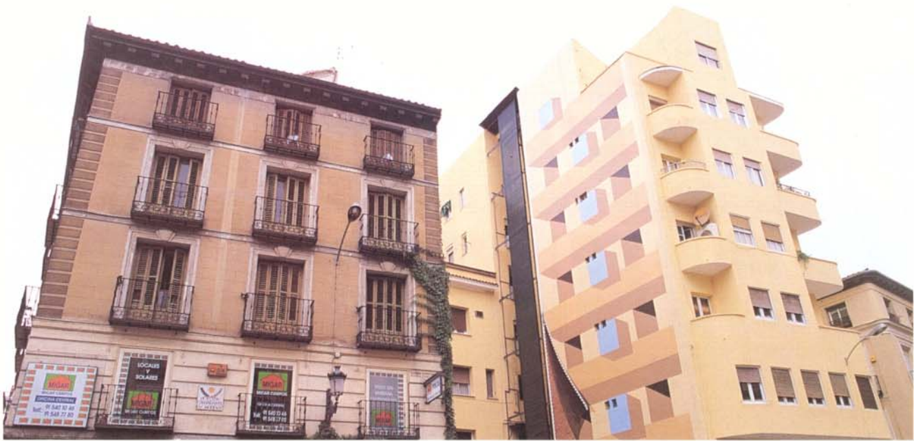
Madrid, primera ciudad en poner en marcha la ITE, cuenta ya con datos sobre el estado de los edificios revisados.
