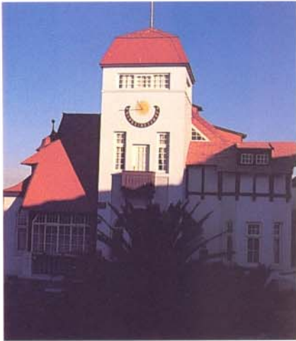
Edificio de corte modernista en la remota Lüderitz (Namibia).
