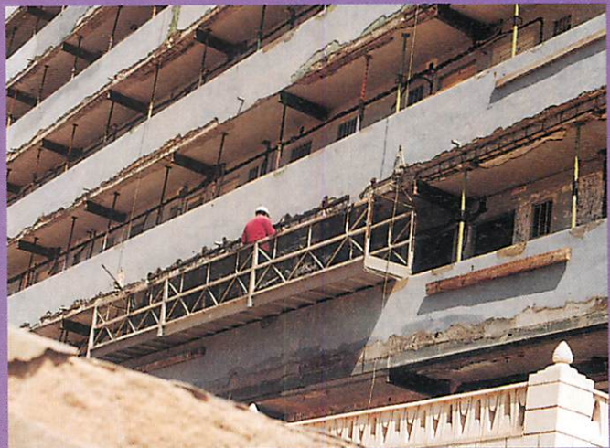
Figura 5. Reparación de una estructura de hormigón armado dañada por corrosión.
