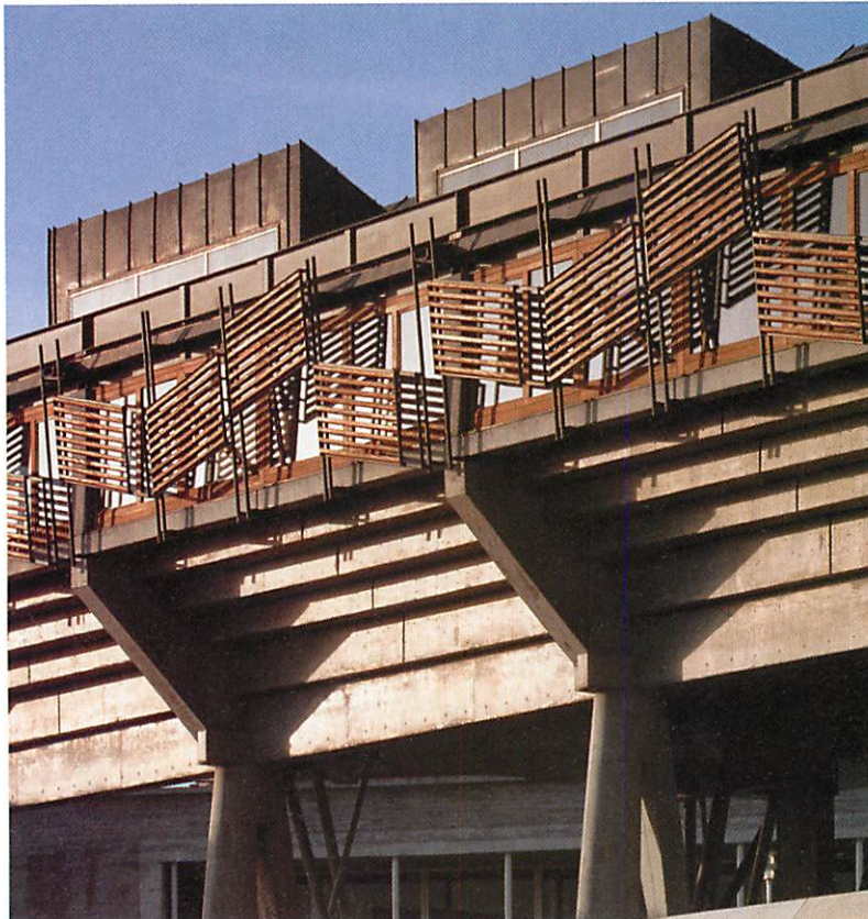
El Aulario se articula mediante un conjunto lineal de cinco bloques que se levantan 5 metros sobre su cota de asiento.
