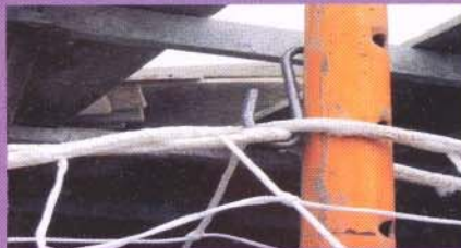
Proceso de montaje de las redes de seguridad bajo forjado reutilizables (Sistema B).
