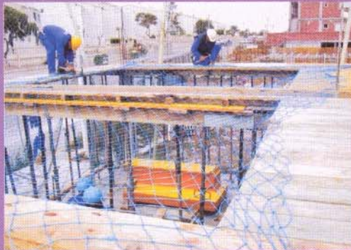
Proceso de colocación de las redes de seguridad de uso único en encofrados de madera para forjados unidireccionales con vigas de cuelgue (Sistema A).
